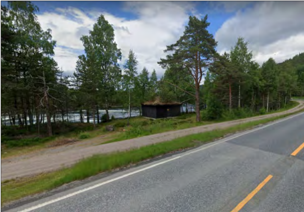
Figur 35 Eksisterende silhus for anlegget. Kilde: Google Maps
