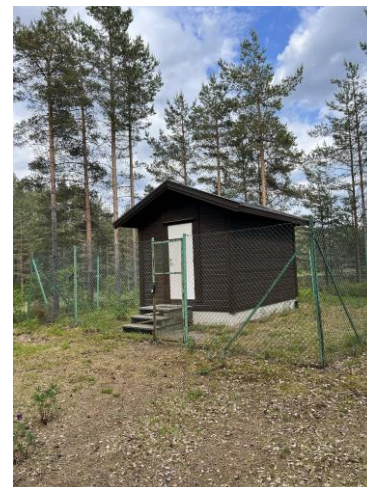
Figur 6. 1 av 2 Brønnpumpehus, bildet er tatt ved befaring.
