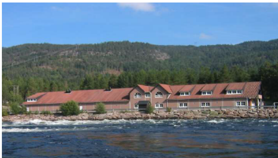
Figur 1: Dagens bygningsmasse på eiendommen
